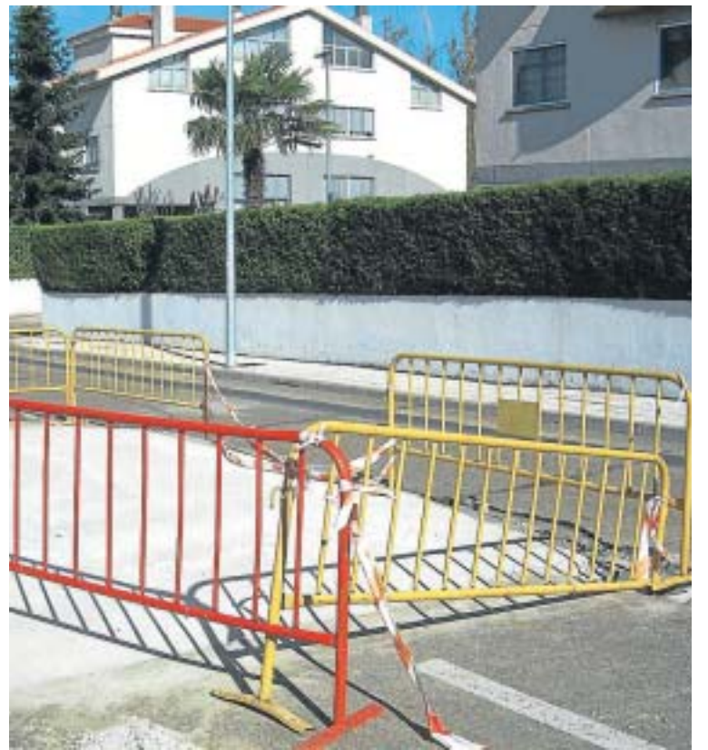
El nuevo badén que se está instalando en la urbanización El Viso./EÑE
