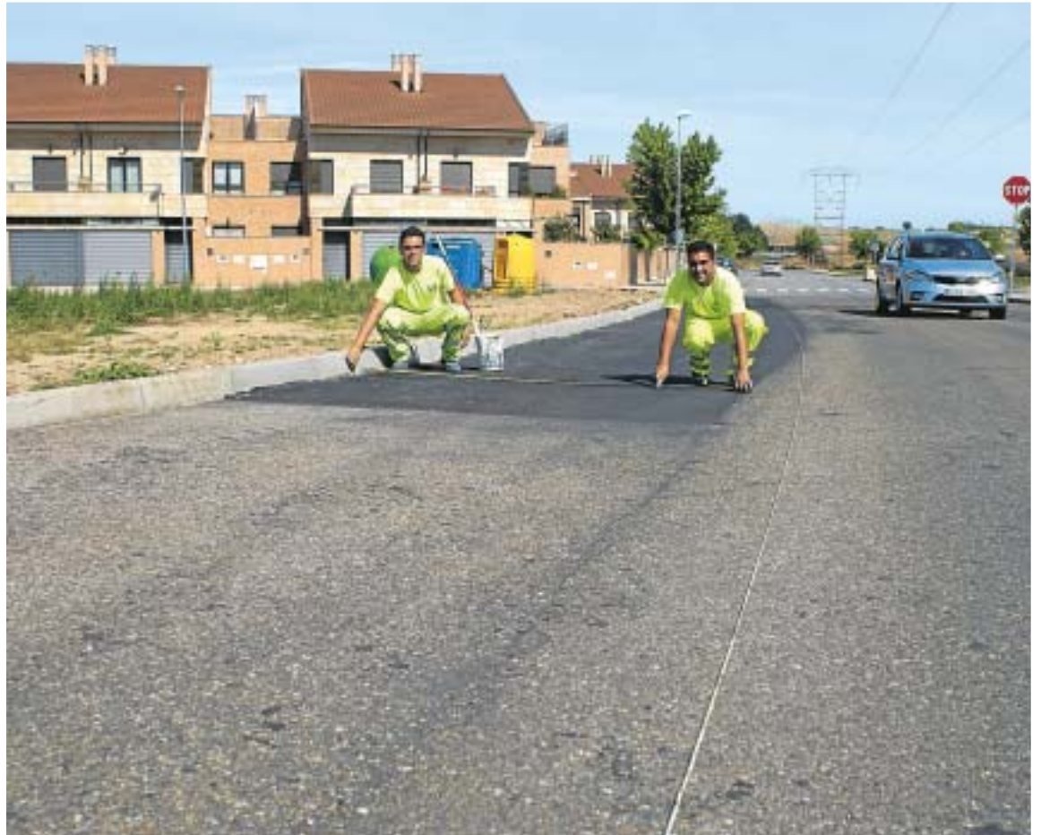
Los operarios han iniciado las obras del carril bici con las marcas de perimetración del futuro trazado./EÑE
