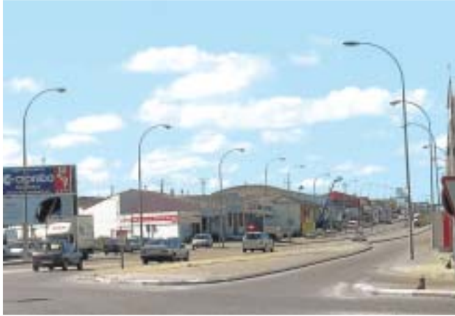
El cambio de luminarias permitirá un gran ahorro en el polígono./EÑE
