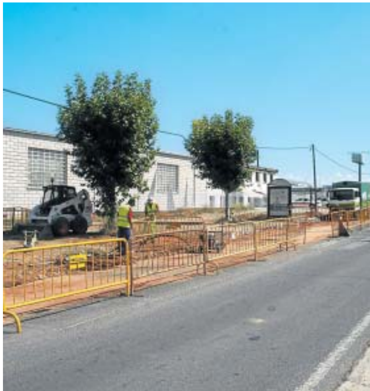
La empresa adjudicataria ya ha iniciado las obras en el primer tramo./EÑE
