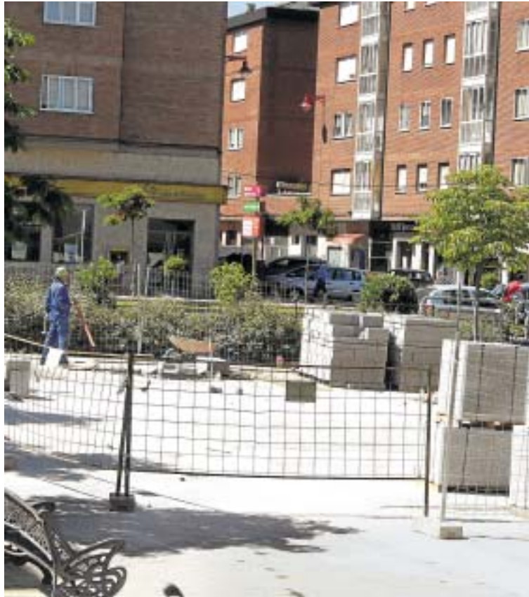
Los obreros ultimán estos días la colocación del empedrado de la plaza./EÑE
