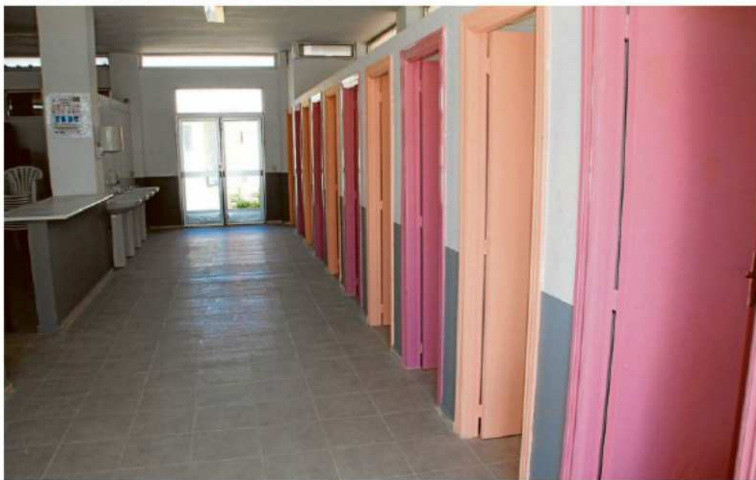
Las obras han permitido renovar las zonas comunes de vestuarios y baños y el acceso al recinto. | EÑE
