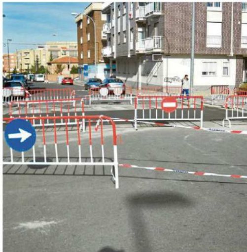
Las obras de los pasos elevados en la calle Francisco Maldonado. | EÑE
