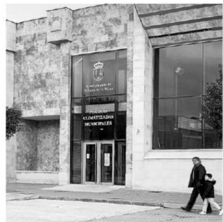
La piscina climatizada municipal permanece cerrada. | ENE
