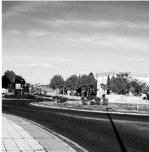
El Ayuntamiento renovará el firme de la rotonda. | EÑE
