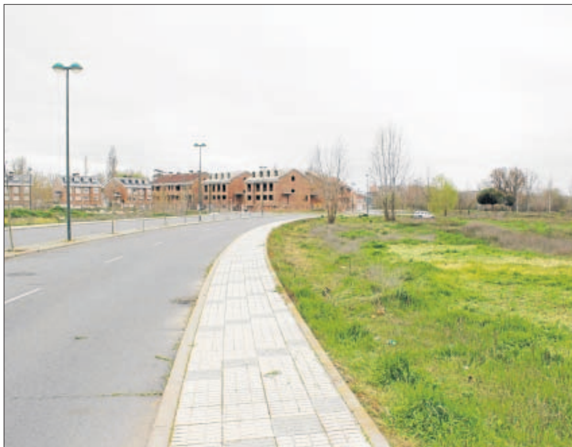
Parcela donde estará situado el nuevo colector que unirá La Fontana con el bombeo situado en la Serna.
