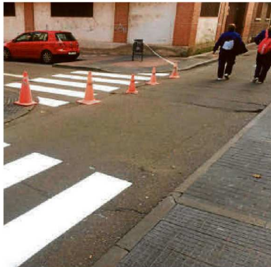
La pintura de la señalización horizontal también se ha renovado. | ENE
