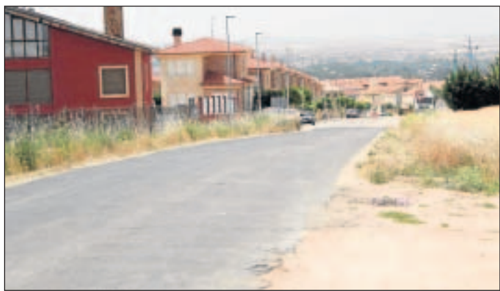
Imagen del comienzo de la carretera situado en el municipio de Cabrerizos. MARJÉS
