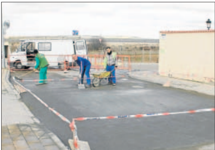
Los operarios trabajando en las calles de la urbanización Aldebarán.
