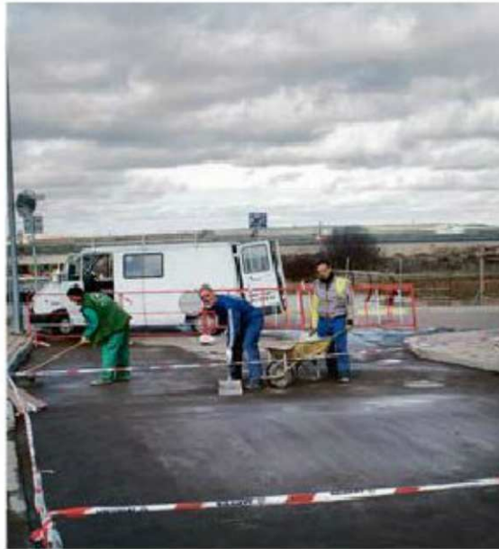
Los operarios trabajan en la instalación de los pasos elevados en Aldebarán./EÑE
