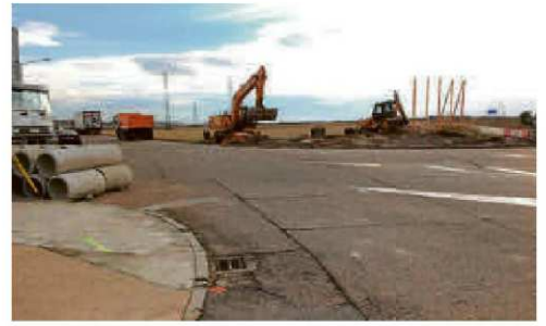
Las máquinas ya trabajan en la creación de la nueva rotonda. | ENE
