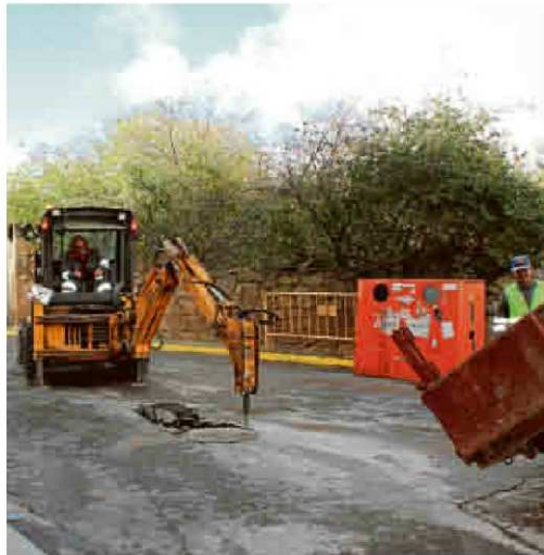
Los operarios municipales ejecutan las obras del nuevo aliviadero. | ENE
