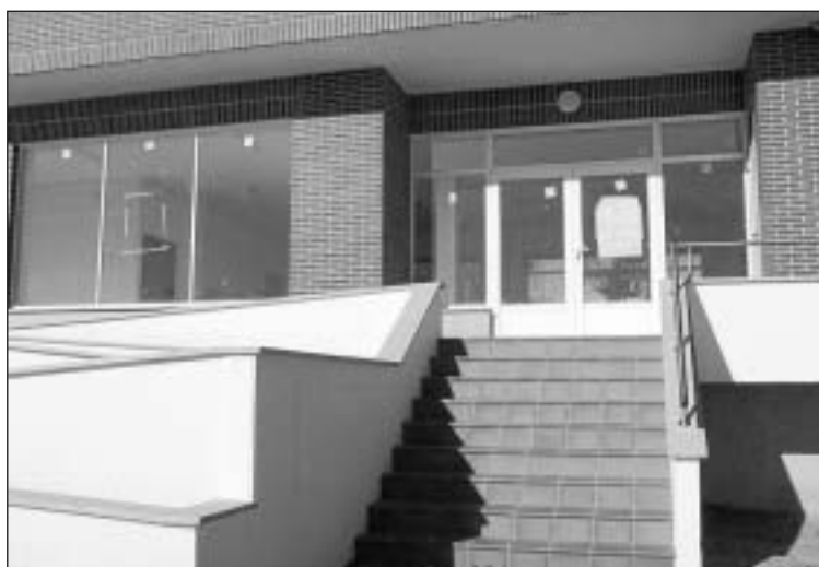
Las nuevas instalaciones de la cafetería, pendientes ahora de equiparse para abrir. MARJÉS
