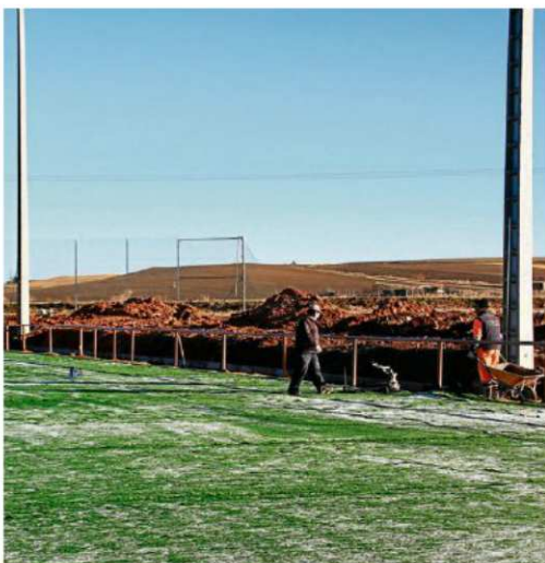
Las obras para instalar gradas del campo de fútbol están en marcha. | ENE
