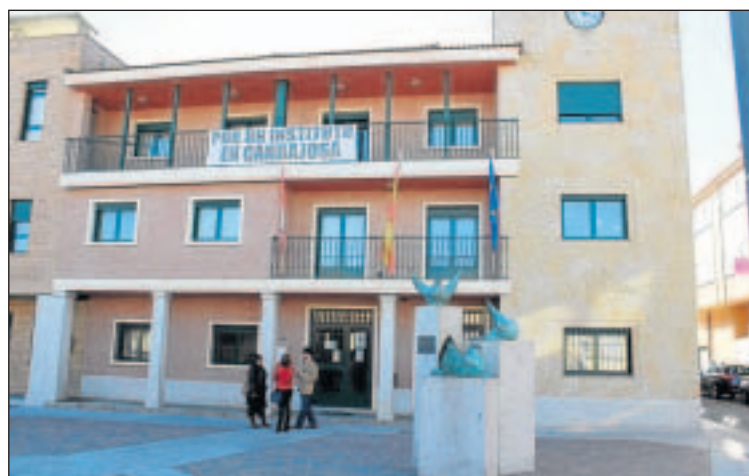
Imagen de la Casa Consistorial de Carbajosa de la Sagrada.
