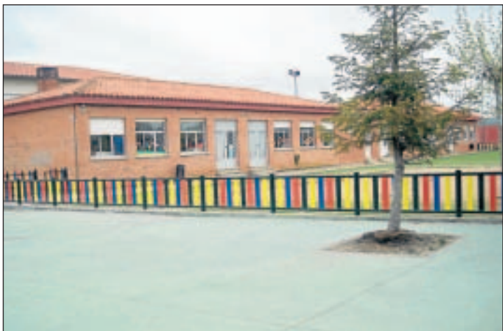
Valla instalada en el Colegio de San Blas de Santa Marta de Tormes.
