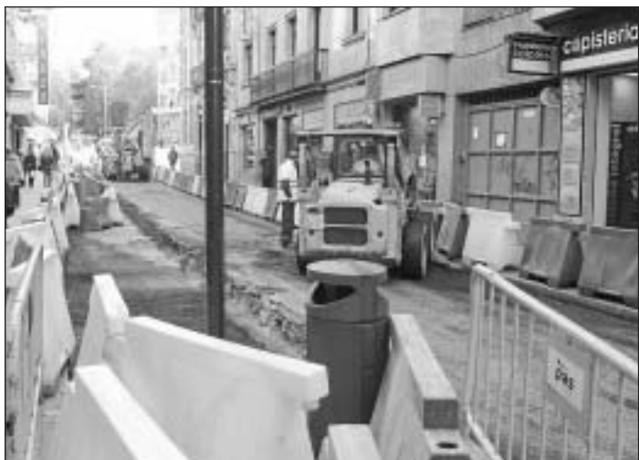
Las obras en la calle Azafranal avanzan a buen ritmo.
